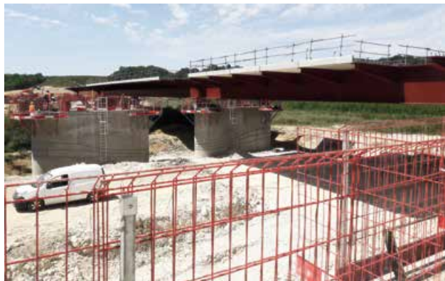
Lançage du tablier du pont sur la Gimone (Gers)
