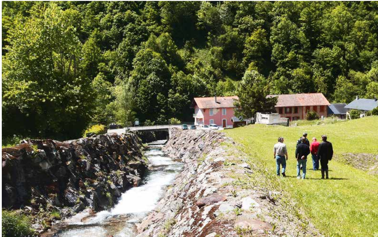
Digue à empiérement
