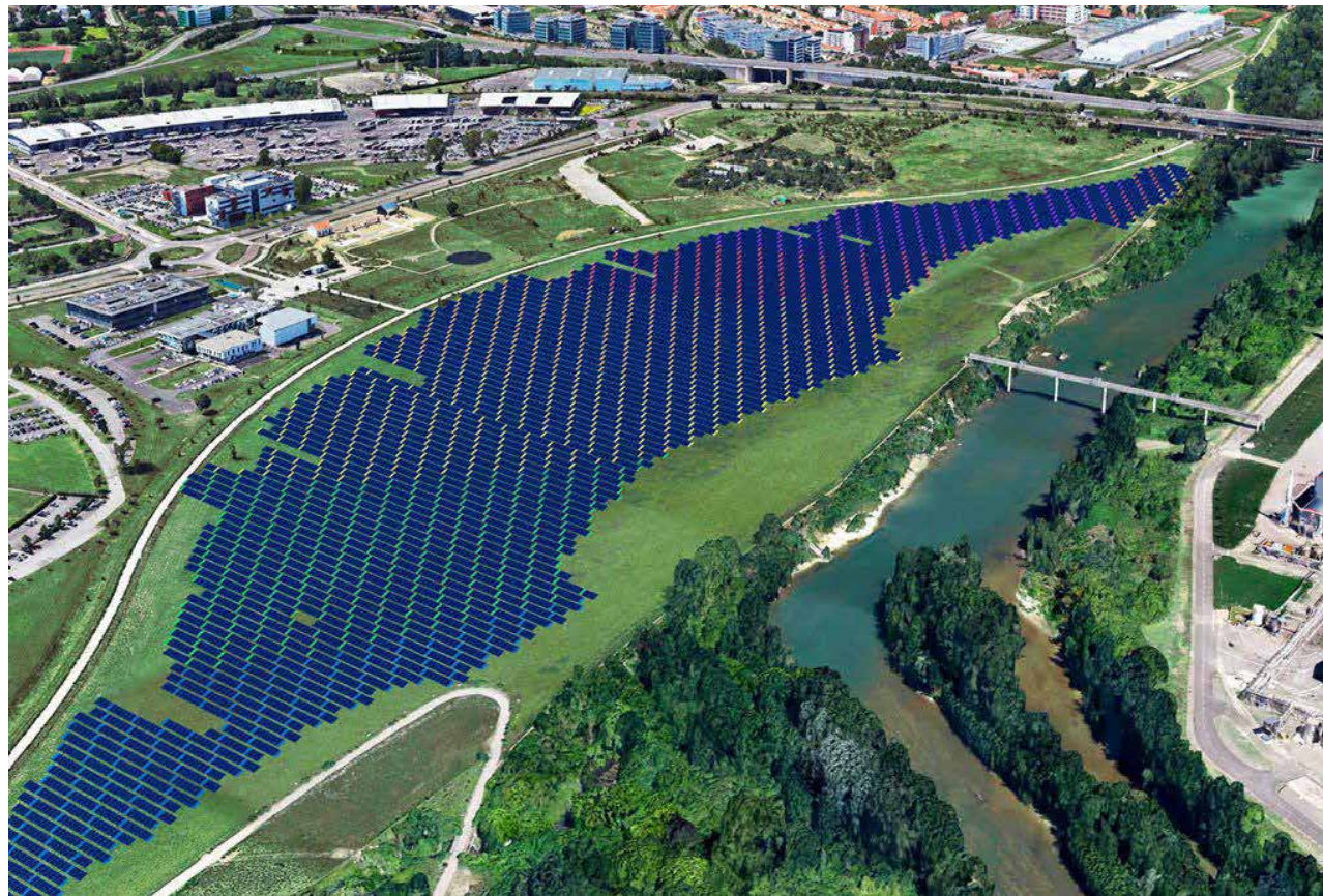
Vue aérienne du projet (Haute-Garonne)
