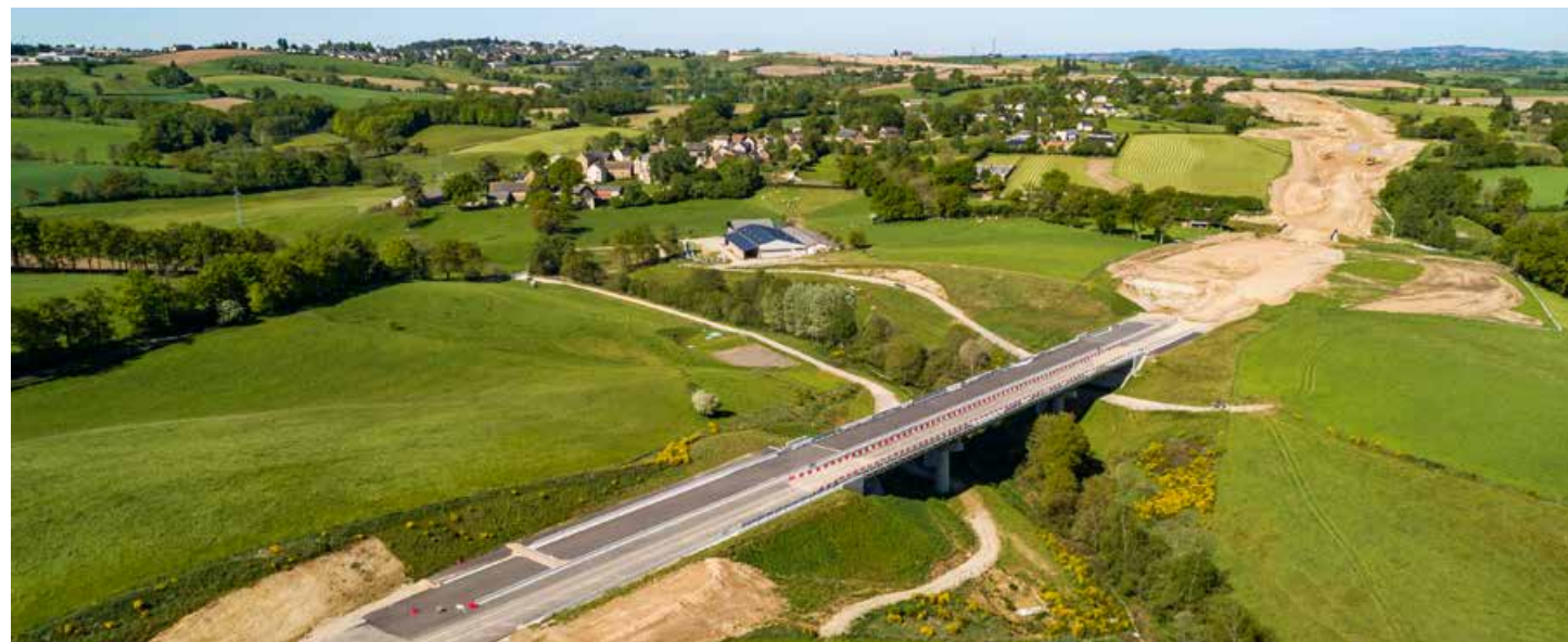
Viaduc du Lenne et tracé de la RN88 (Aveyron)
