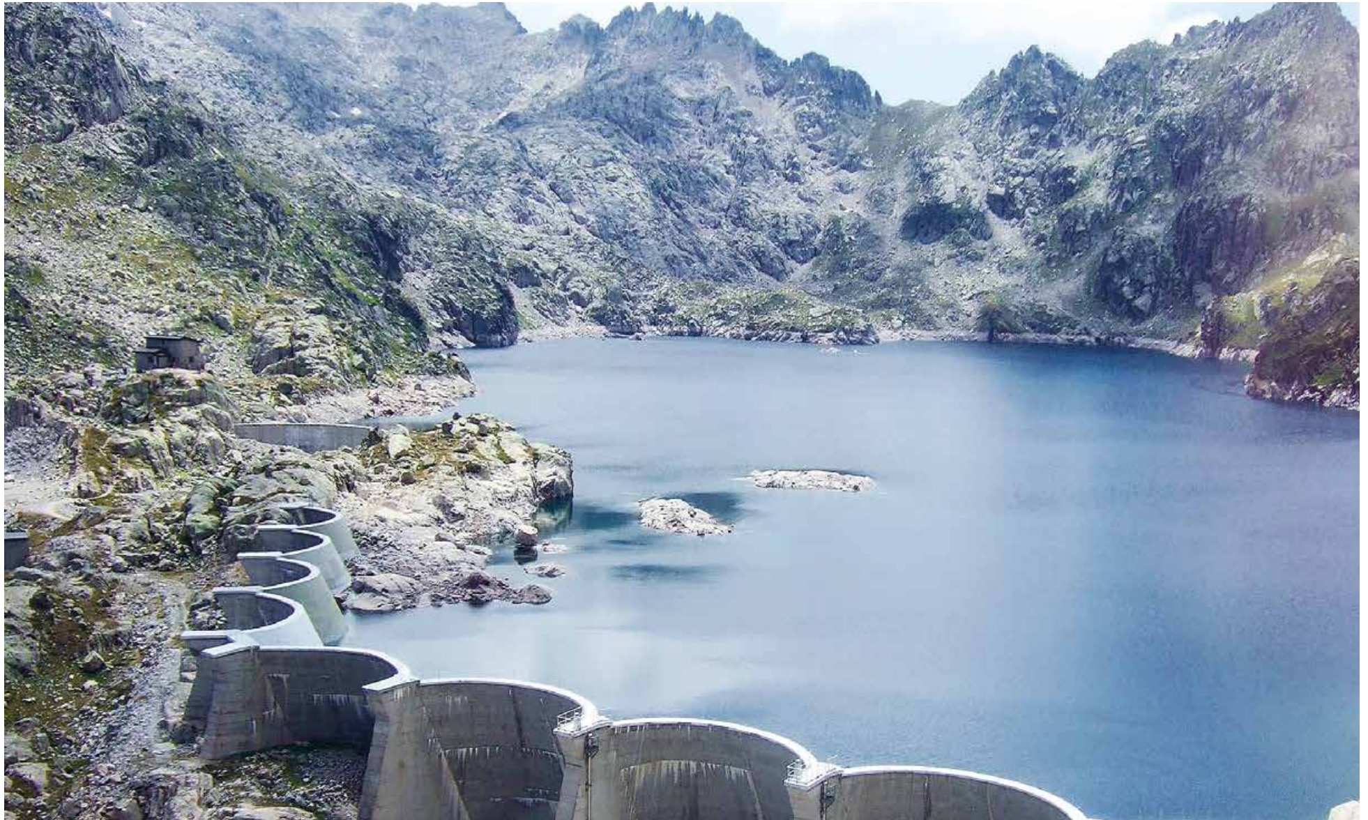
Barrage de Miguelou (Hautes-Pyrénées)
