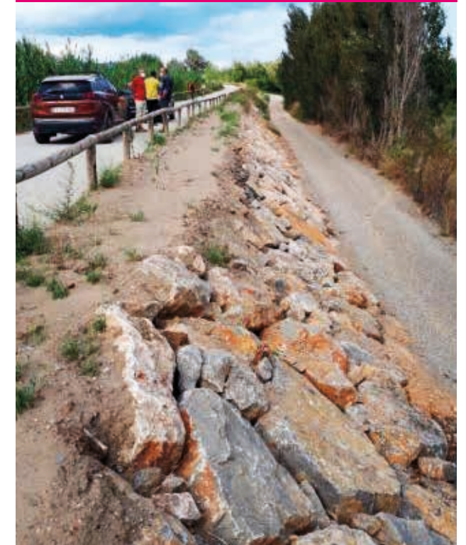
Digues de l'Agly après travaux
