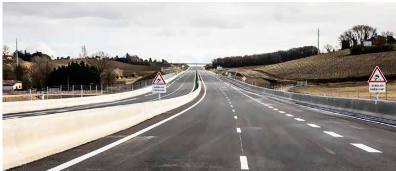
Déviation de Gimont sur la RN124 (Gers)
