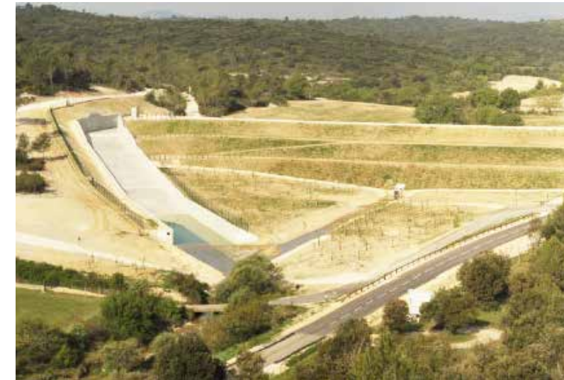
Vue aval du barrage de Saint-Génies-de-Malgoirès
